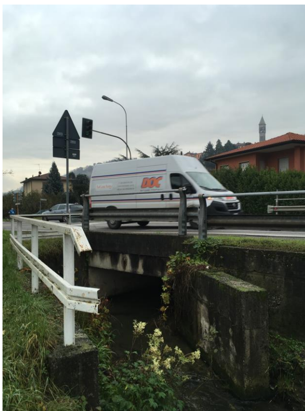
Immagine 3 – Ponte, attraversamento corso d'acqua su SP342, alla pk 30+444 (foto 3 elaborato G.3)
